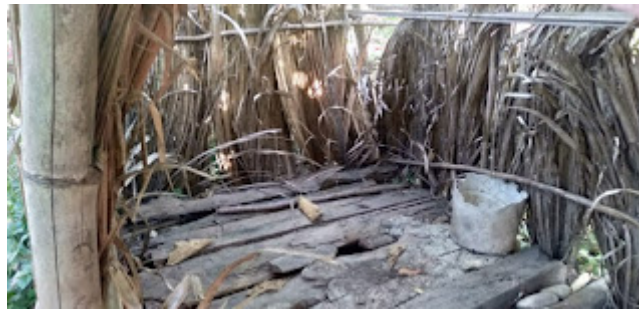
Kondisi jamban selana ini
