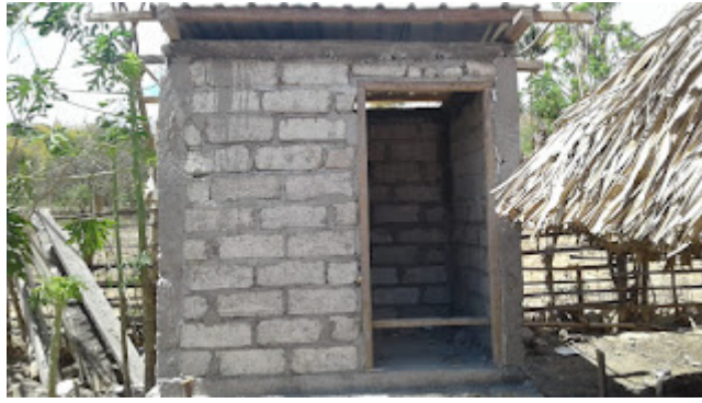
Kondisi jamban setelah dibangun oleh YFSP
